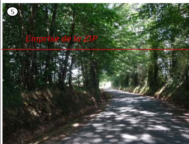
Cette route secondaire reliant Piégut à la D84, présente un linéaire en cavée c'est à dire entre deux talus plantés et présente un enjeu fort
